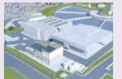
上ヶ原浄水場完成イメージ
