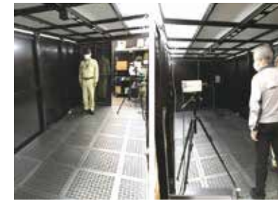
微粒子可視化システム (VIEST) を用いた実証実験の様子
