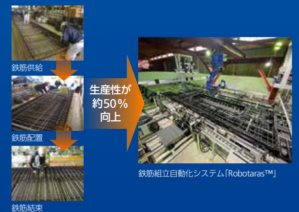
ロボットによる鉄筋の配置と結束作業の自動化
