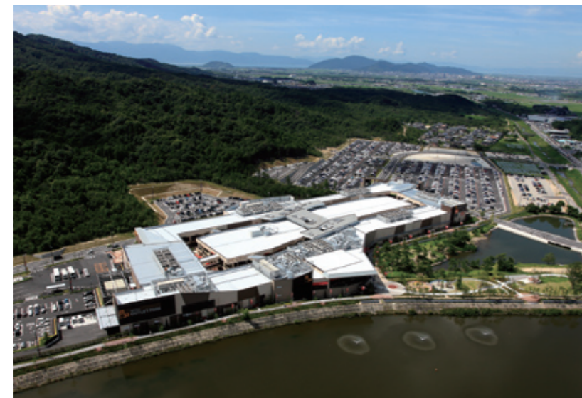
南東側から見た全景
