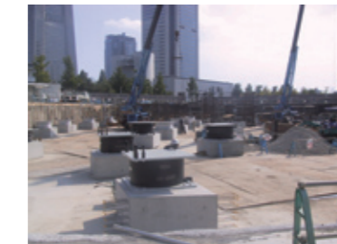
免震装置の施工状況
