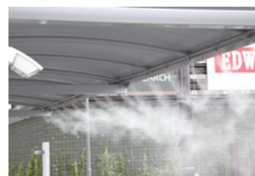
ミストシャワー バスシェルターに消費電力の少ないミストシャワーを設置
