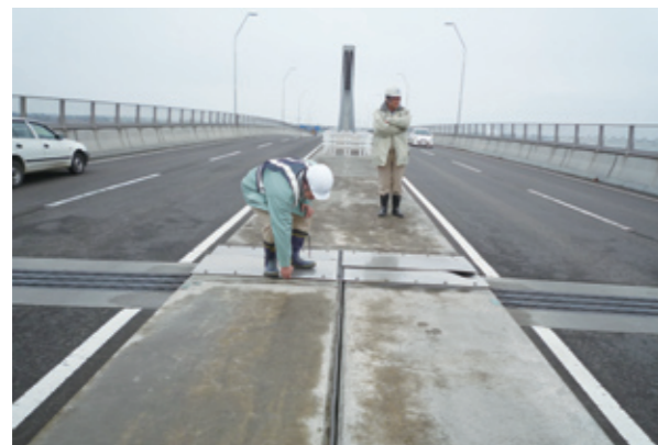
地震後の橋梁調査状況
