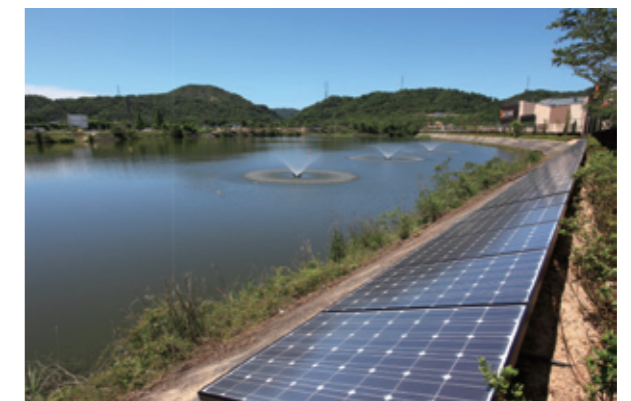
太陽光発電パネル 護岸に設置し、フロート噴水や電気自動車用充電スタンドの動力源として利用
