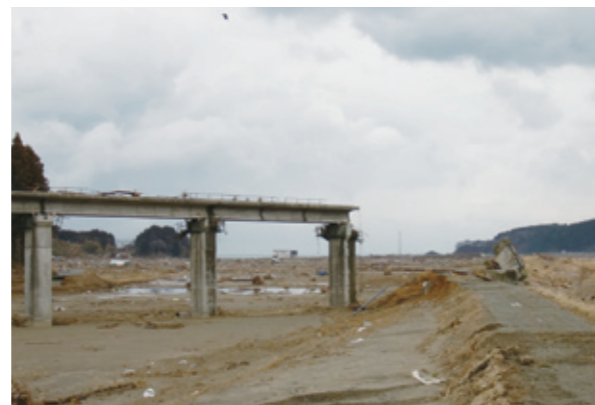
橋梁被災状況（落橋した津谷川橋）
