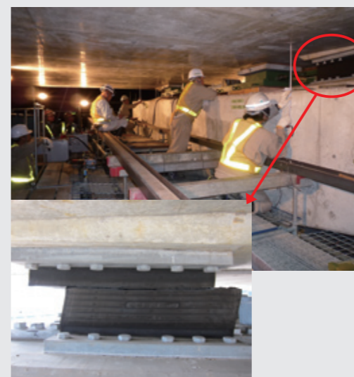
支承の損傷（ゴム沓破断）状況とジャッキアップ状況
