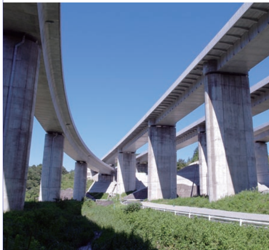
工事件名：第二東名高速道路 的場高架橋他2橋（PC上部工）工事 発注者：中日本高速道路株式会社 東京支社様 2011年度プレストレストコンクリート技術協会賞【作品賞】受賞
