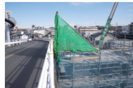
橋脚躯体と跨線橋が隣接するため、飛散防止・立入禁止措置を実施
