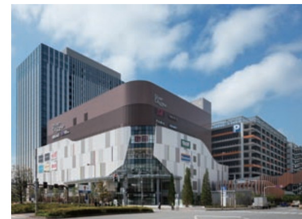
工事件名：（仮称）青海Q街区計画 商業・駐車場棟新築工事 発注者：青海Q区画計画特定目的会社様
