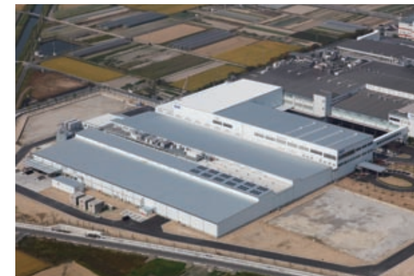
工事件名：株式会社DNPテクノバック関西 田辺工場・増築 発注者：大日本印刷株式会社様
