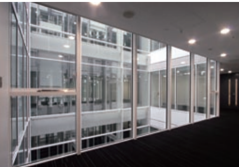
基準階コア部分の吹抜け
