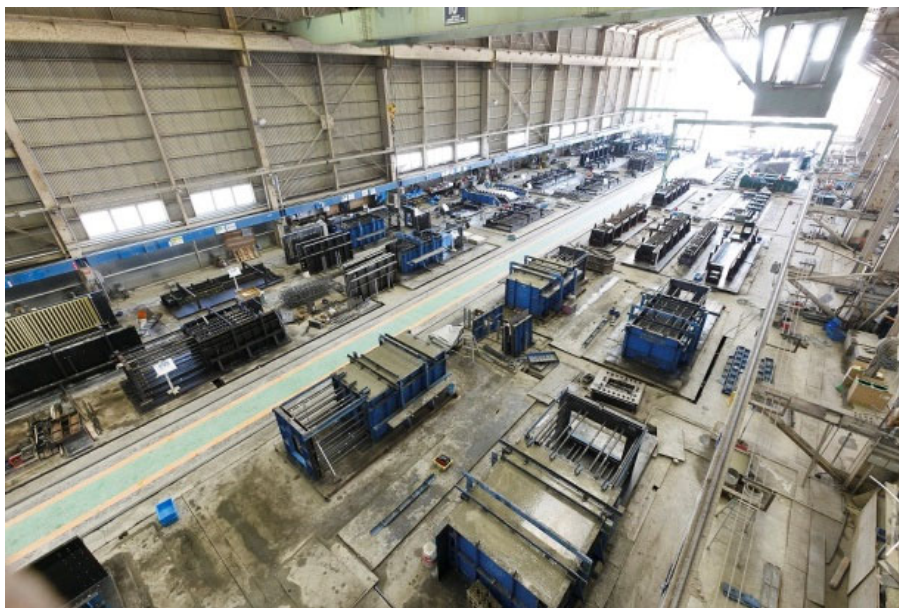
【Overview of PCa factory production line】
