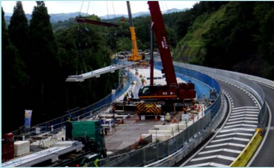
3橋同時床版取替 (中国道大峰橋他2橋)
