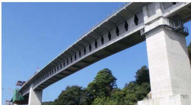
世界初の複合橋技術、蝶型形状のコンクリートパネルを用いて実現したバタフライウェブ橋「田久保川橋」
