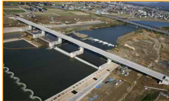
【20/3期 主な完成工事】
