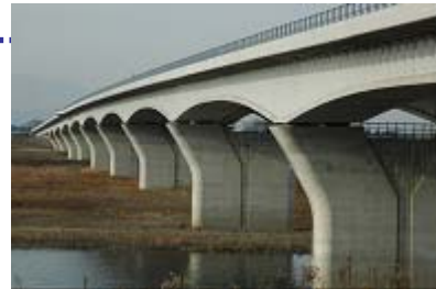
北関東自動車道 鬼怒川橋
