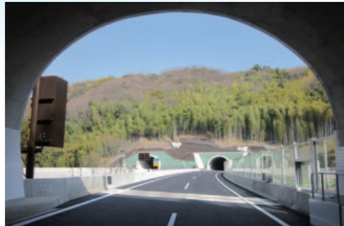
工事件名: 京都第二外環状道路西山トンネル 奥海印寺工区工事 発注者: 国土交通省 近畿地方整備局 様
