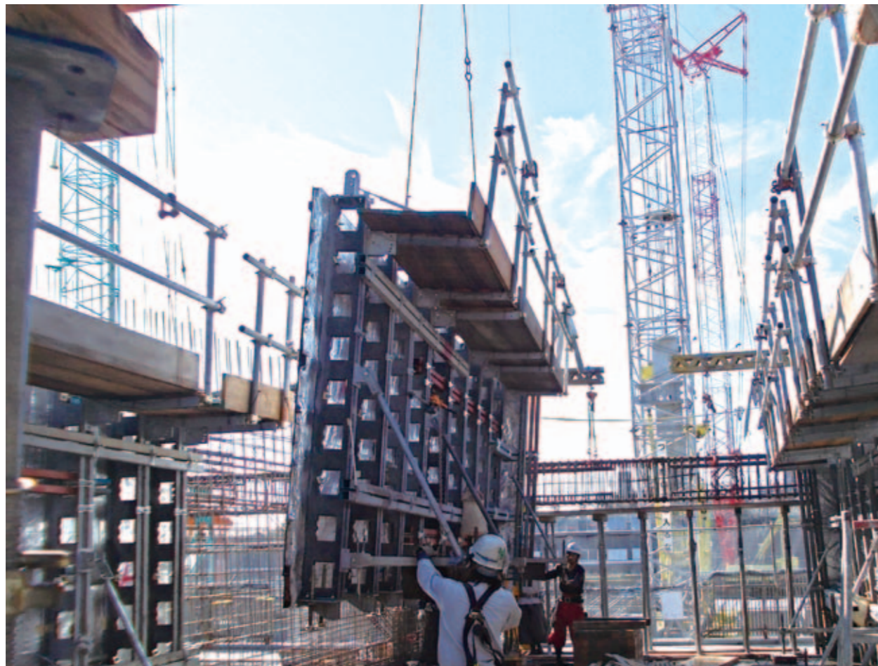
大型鋼製型枠の設置状況
