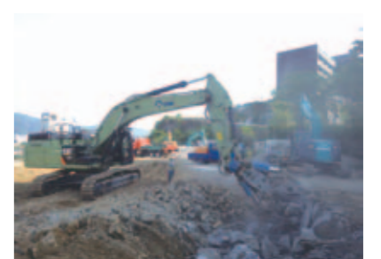
平成25年度宮古市鉾ヶ崎・光岸地区整備工事
