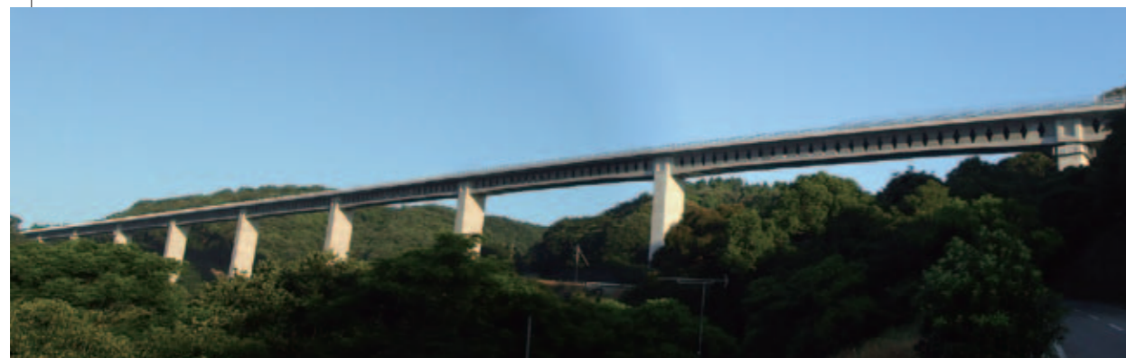
工事件名: 東九州自動車道 田久保川橋(PC上部工) 工事 発注者: 西日本高速道路株式会社九州支社 様 ※平成25年度土木学会田中賞(作品部門)受賞 公称: 寺迫ちようちよ大橋
