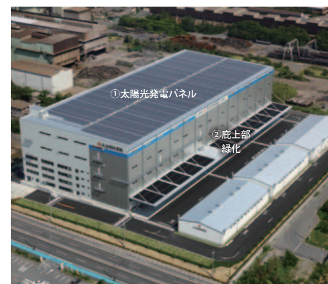
発注者:丸全昭和運輸株式会社様 物件名:丸全昭和運輸株式会社 関西支店 堺倉庫営業所
