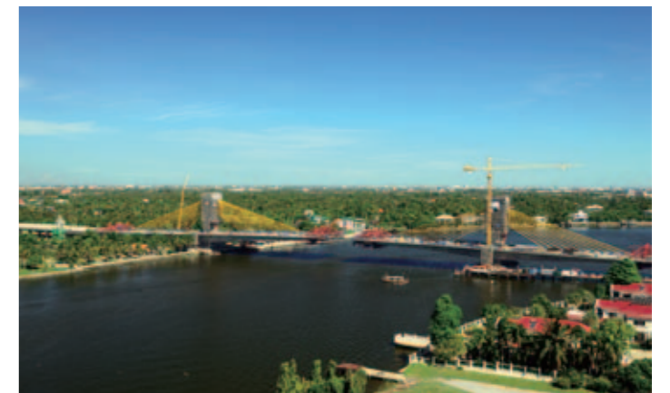
工事件名: ノンタブリ橋建設工事(2014年竣工予定) 発注者: タイ王国 運輸省地方道路局 様
