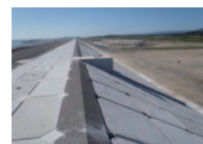
仙台湾南部海岸中浜工区坂元地区復旧工事
