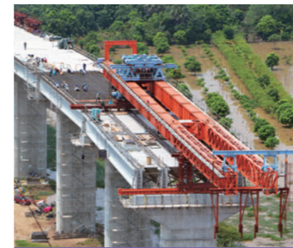
アプローチ橋施工
