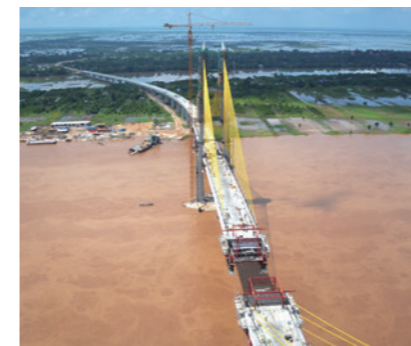
下支えワゴンによる片持ち架設状況
