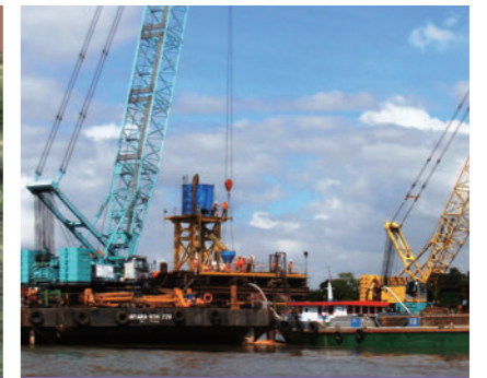
河川内での場所打ち杭施工状況
