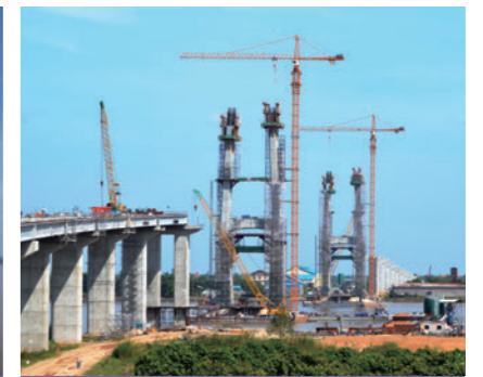
主橋部施工状況
