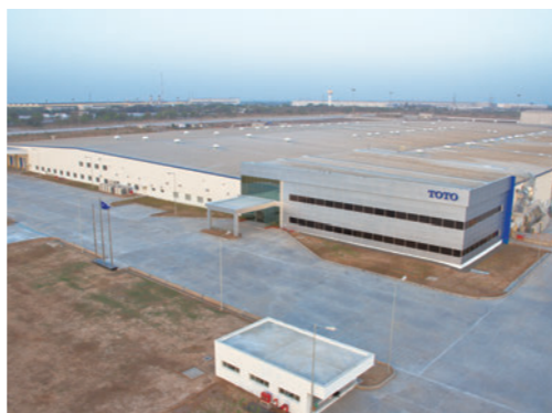
工事件名:TOTOグジャラート工場新築工事 発注者:TOTO India Industries Pvt. Ltd.
