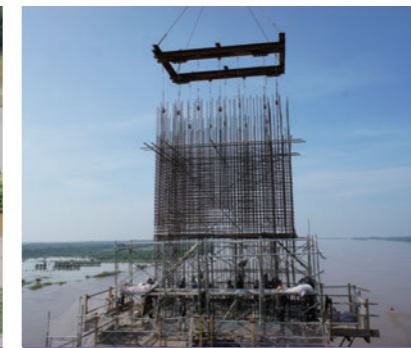
主塔鉄筋プレファブ架設
