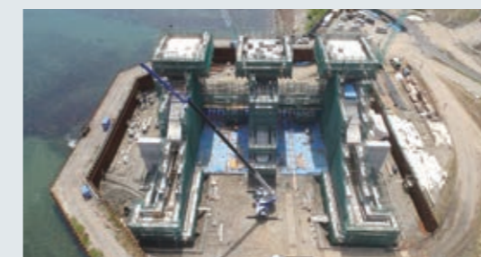
小白浜地区海岸災害復旧工事(岩手県)
