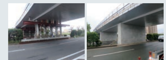
東原橋(熊本県)の応急復旧工事(左)と耐震補強完了後(右)
