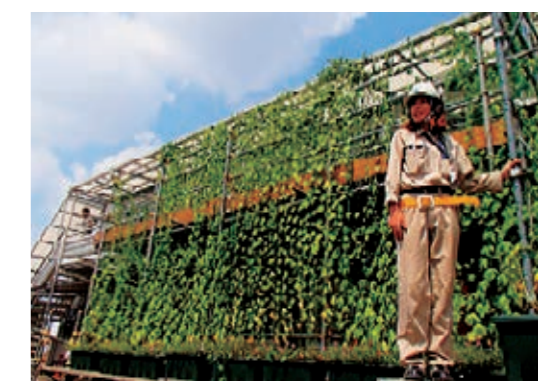
東京建築支店 板橋区蓮根三丁目計画作業所
