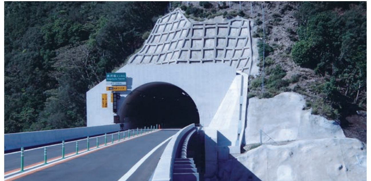
近畿自動車道 紀勢線黒崎トンネル (発注者: 国土交通省)
