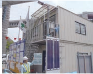
仮囲いパネル 一体型太陽光発電 (システムの設置)
