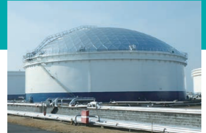
石油製品備蓄タンクウルトラドーム化工事 (発注者: JXエネルギー株式会社)
