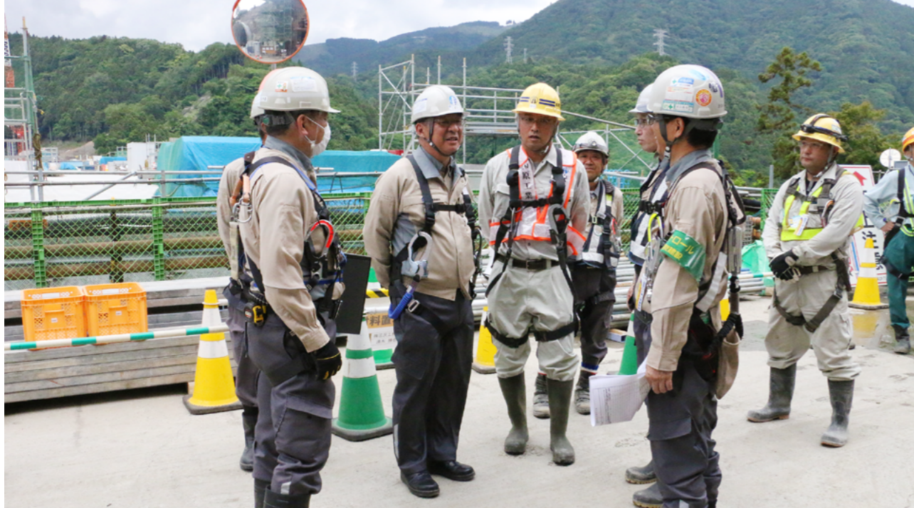
新東名高速道路 山北皆瀬川工事
