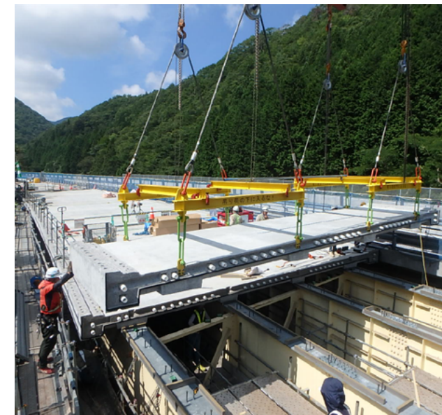
蓼野第二橋他3橋床版取替工事（島根県）
