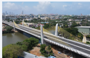
ケラニ河新橋建設事業パッケージ2 エクストラードーズ橋工区
