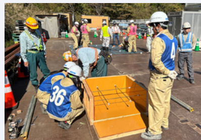
鉄筋結束の作業を体験する様子
