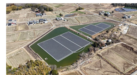
加東市(平池・新池)水上太陽光発電所
