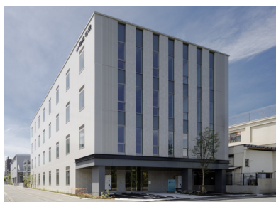
住友電設株式会社 東京工事センター 建替計画
