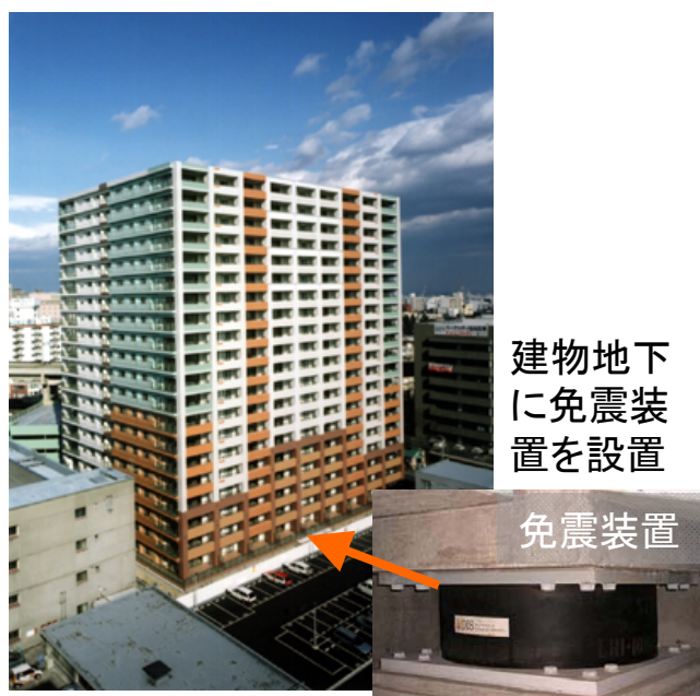
免震高層マンション(仙台)
