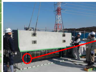
床版と壁高欄のプレキャスト化で 道路規制期間の短縮を実現
