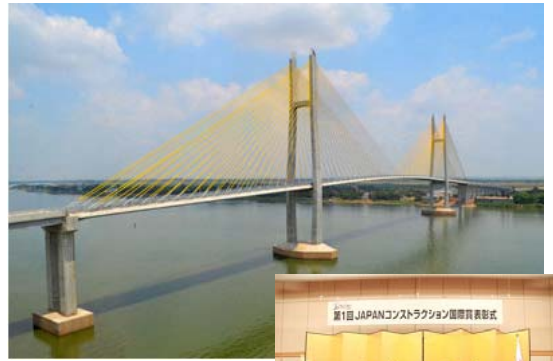
第1回JAPANコンストラクション国際賞受賞 「つばさ橋／ネアックルン橋（カンボジア）」
