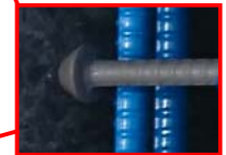
鉄筋端部を円錐台状に 拡径加工した Trunc-head工法
