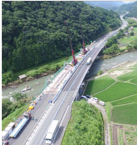
床版取替工事 施工状況
