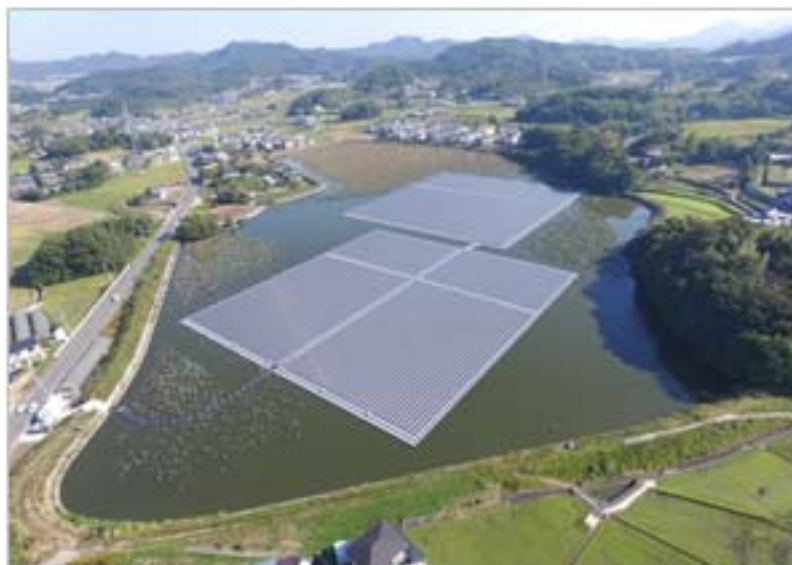
【平木尾池（香川県）水上太陽光発電所（稼働中）】
