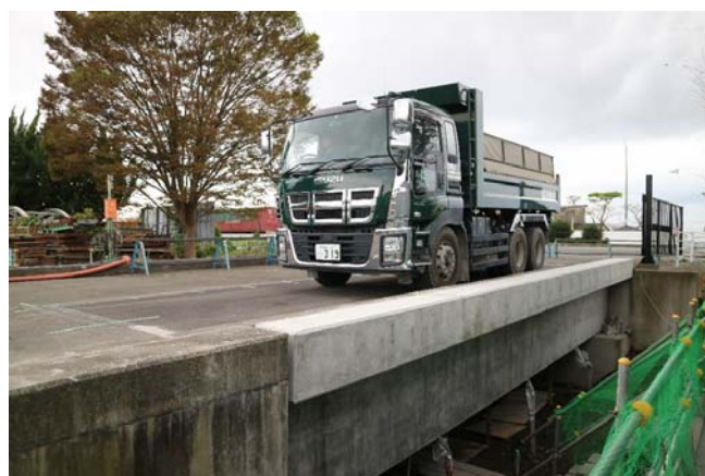
実証橋載荷実験の様子
