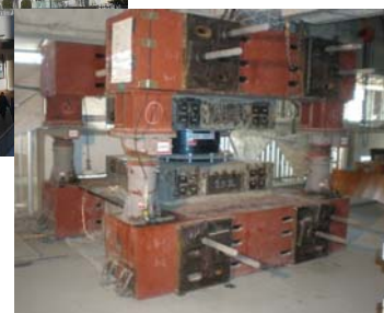
免震装置の設置作業状況
