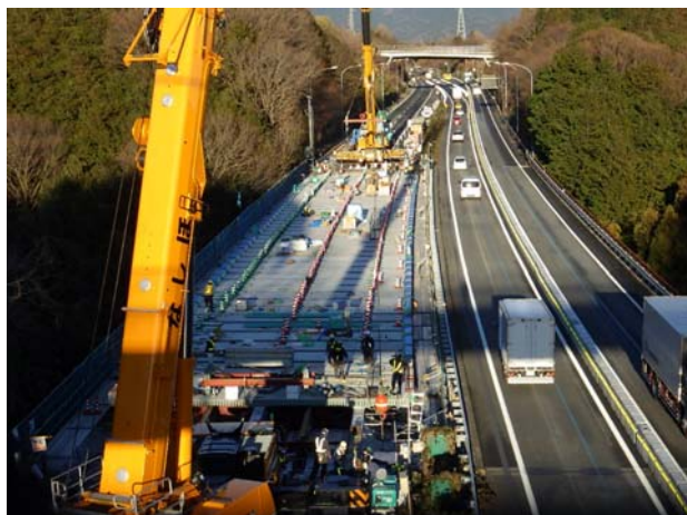
東名高速道路裾野IC沼津IC間 下長窪川橋
