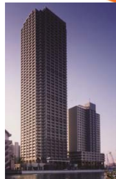
1998年 日本初50階以上 トリニシアビルゲート1号棟
