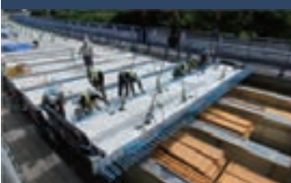
橋梁床版取替工事
