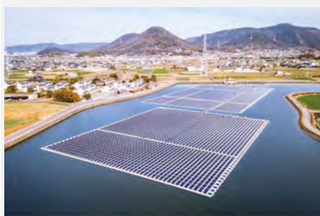
蓮池水上太陽光発電所
