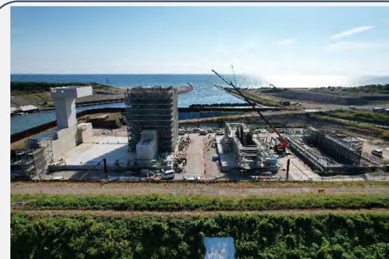
案件名:馬込川 地震・高潮対策工事(水門本体工) 概要 :水門工1式 施工幅 W=90.0m(30m×3径間)
