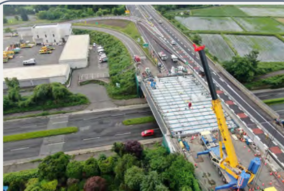
案件名:東北自動車道 仲田橋床版取替工事 概要 :鋼橋の床版取替工4橋 (A=2,240m 2 )
