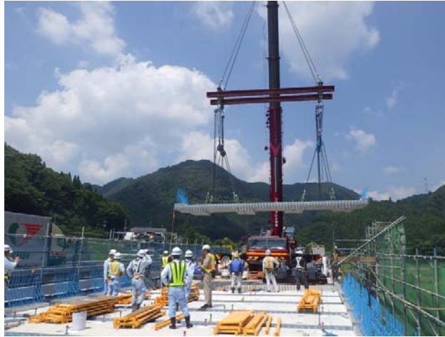
【中国自動車道 (特定更新等) 西川橋床版取替工事】
