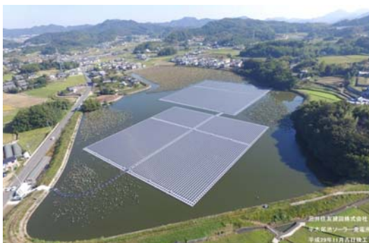
【平木尾池（香川県） 水上太陽光発電所（稼働中）】
