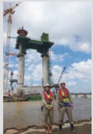
ベトナムホーチミン高速道路建設工事業所にて
