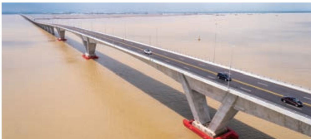
5.4km海上橋部分
