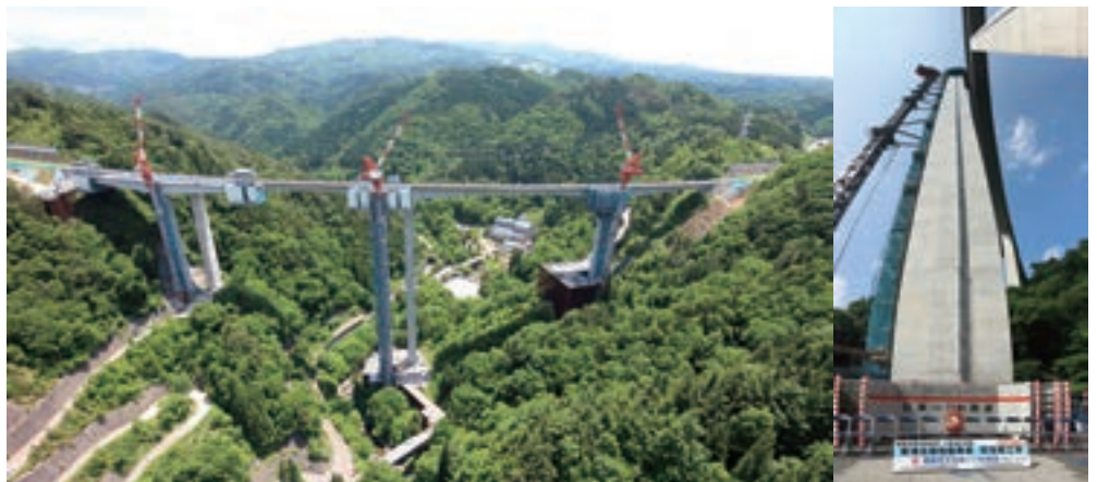
工事風景(全景)
