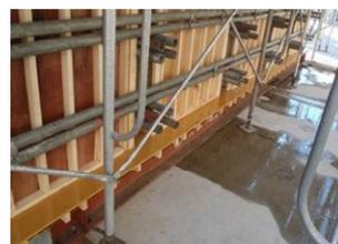
写真-7 透水型枠シート排水状況
