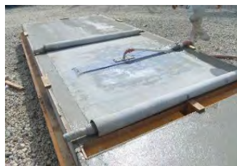
写真-4 真空ポンプ
