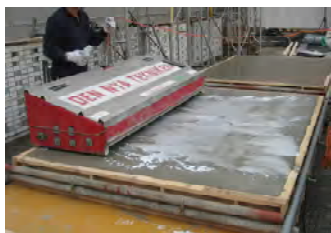
写真-3 天端仕上げシステム
