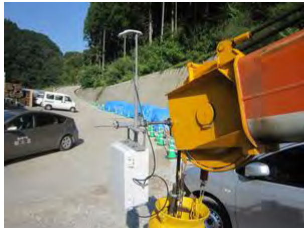
写真-2 ブーム頂点への機器設置状況 (無線方式)
