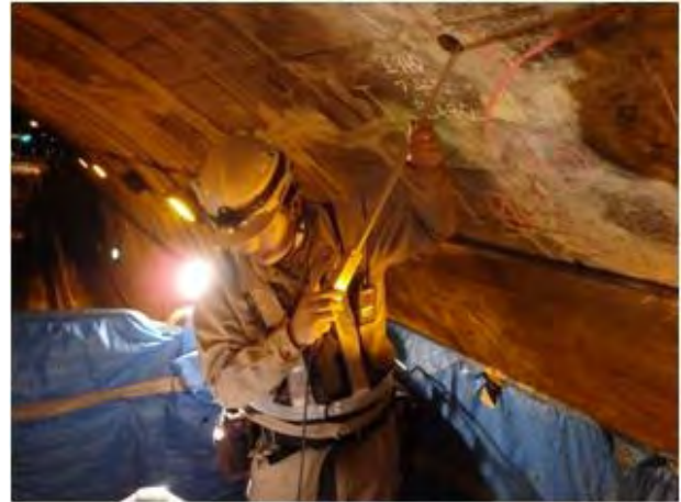
図-7 覆工背面空洞調査状況
