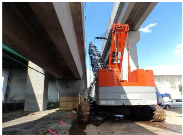
写真-4 営業線近接工事での実施例
