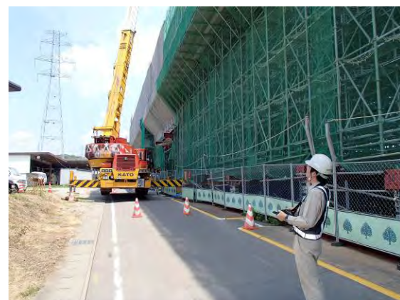
写真-1 送電線近接工事における監視状況
