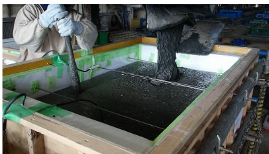
写真-1 コンクリート打込み状況
