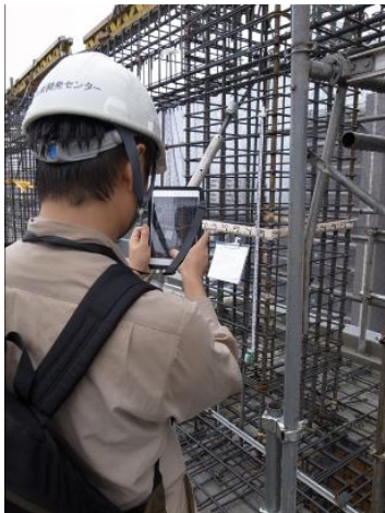
写真-1 配筋検査状況
