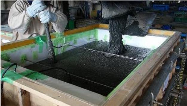
写真-1 コンクリート打込み状況 ( $W/B=12\%$ , 冬期)
