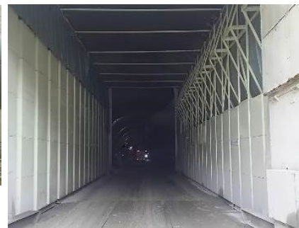
写真-1 吸音装置の現場設置状況
