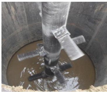
写真-1 ロッドに取付けた攪拌
