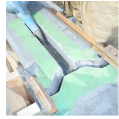
写真-3 スリット
