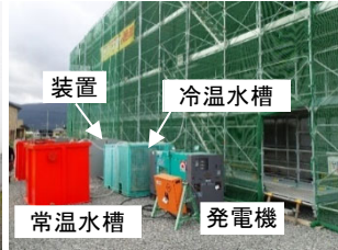
写真-5 装置配置状況
