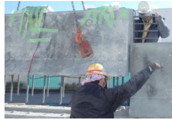
写真-2 壁高欄同士の接合
