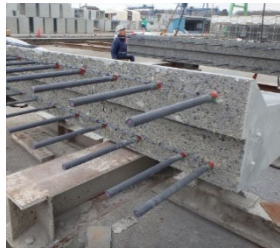
写真-1 壁高欄下面
