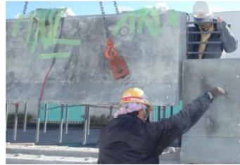
写真-2 壁高欄同士の接合
