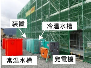
写真-5 装置配置状況
