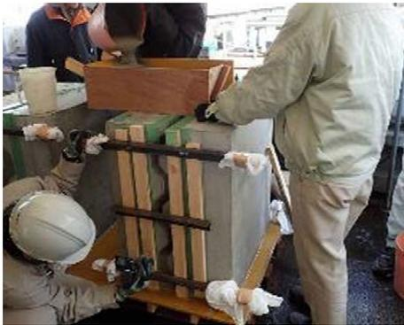
写真-1 XSの充填作業の様子
