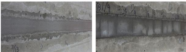
写真-2 雨上がり 接合目地部底面の様子
