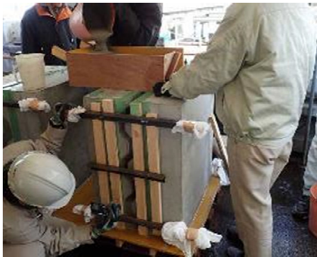
写真-1 XSの充填作業の様子
