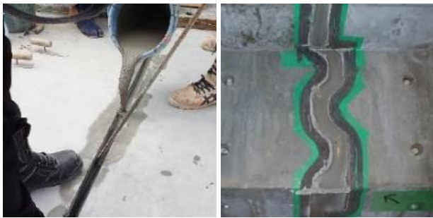
写真-3 充填の様子
