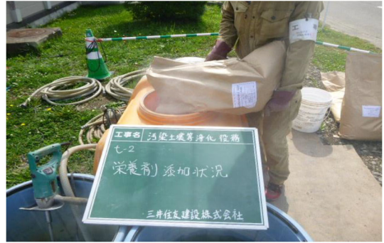
写真-2 バイオ製剤等の投入
