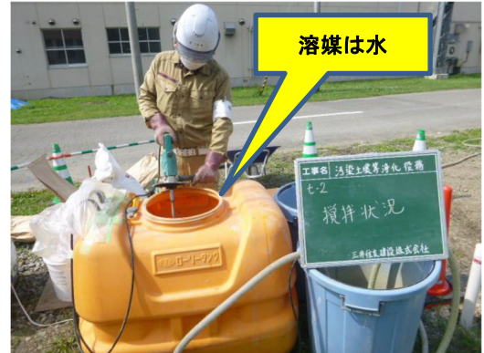
写真-3 攪拌混合
