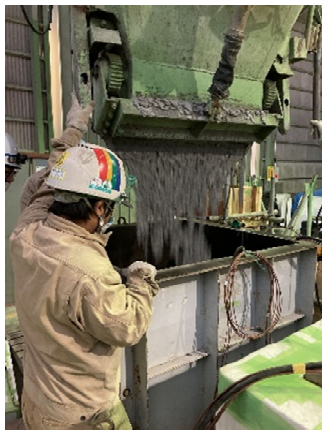
写真-2 模擬柱部材の打込み状況
