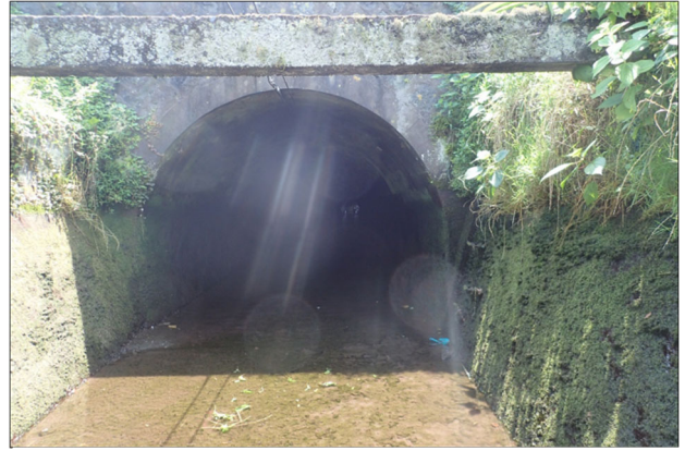
写真-1 開水路コンクリート壁面状況
