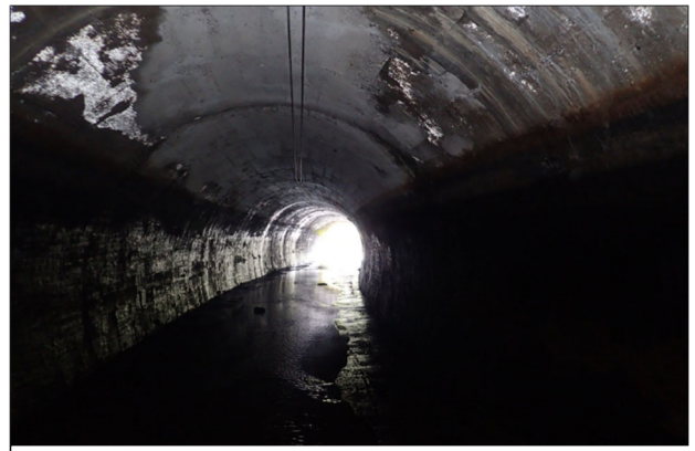
写真-2 水路トンネル構内状況
