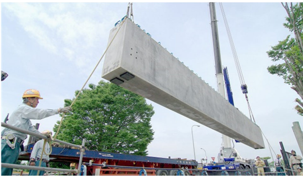
写真-1 実証桁の架設状況
