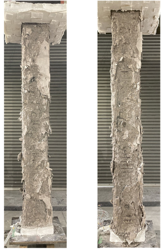
写真-4 荷重加熱試験後の試験体外観
