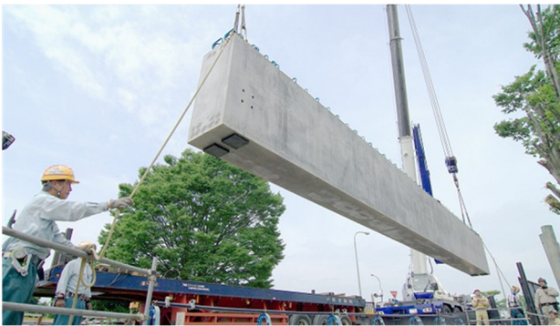
写真-1 実証桁の架設状況
