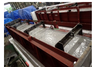
写真-3 打込み完了後
