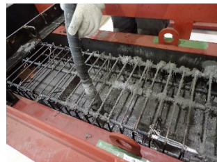
写真-2 打込み状況
