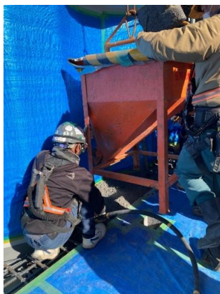
写真-2 STC50N の打設状況
