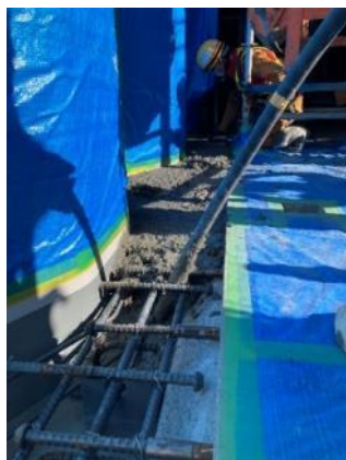
写真-2 STC50N の打設状況
