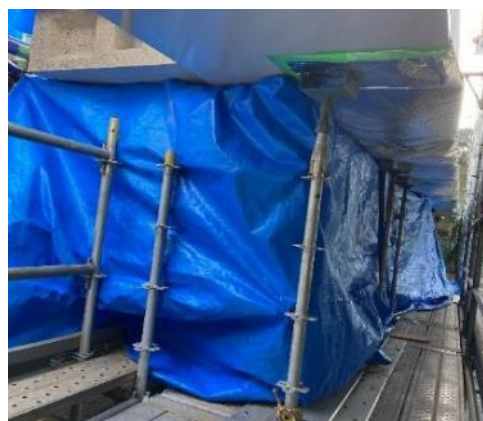
写真-4 冬期施工時の養生対策状況
