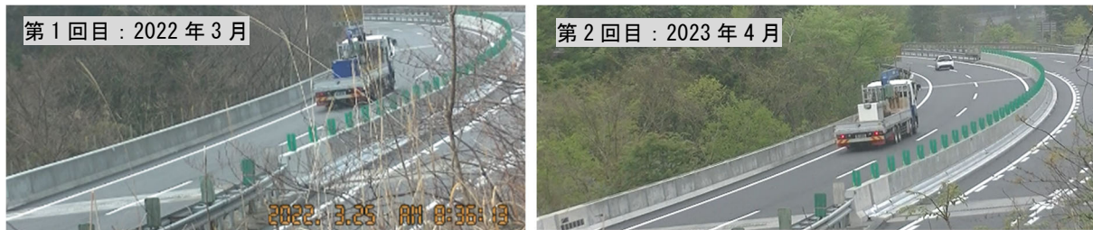
写真-3 車両走行試験
