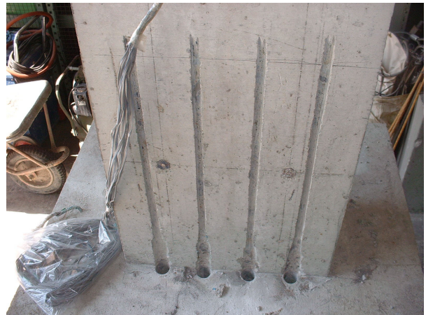
写真-1 切削完了後の状況
