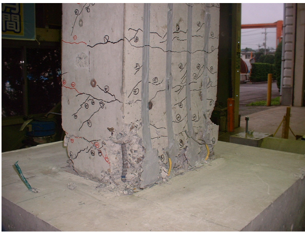
A-1 (ロッド補強) 写真-2 破壊状況
