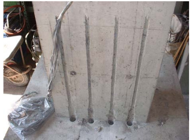
写真-1 切削完了後の状況
