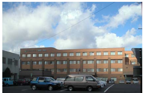
写真-1 外断熱工法を採用した病院 (北海道千歳市)
