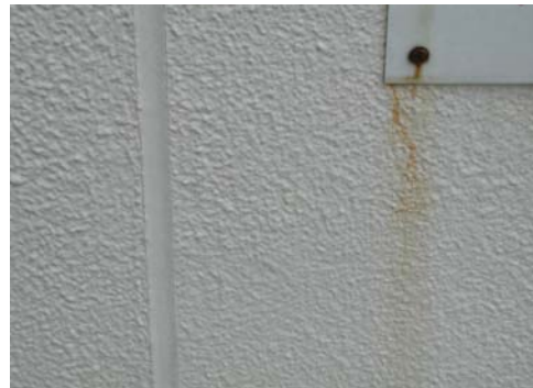
写真-7 E 建物 錆汁による汚れ状況
