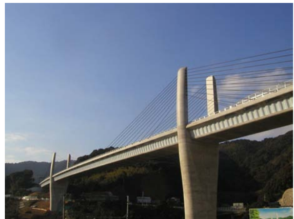
写真-1 日見夢大橋の全景
