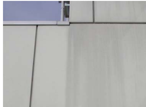
写真-2 A建物 外壁面の汚染状況
