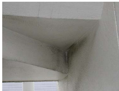
写真-9 G 建物 塵埃の蓄積による汚れ状況
