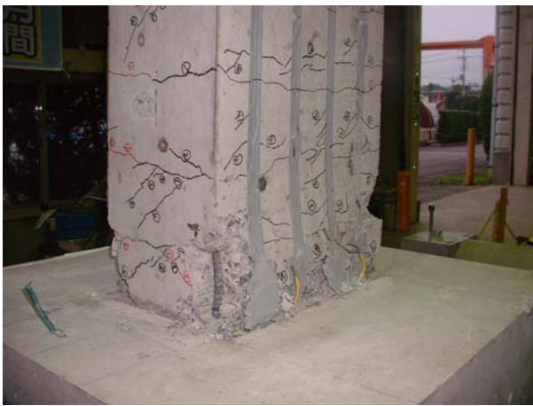
A-1 (ロッド補強) 写真-2 破壊状況
