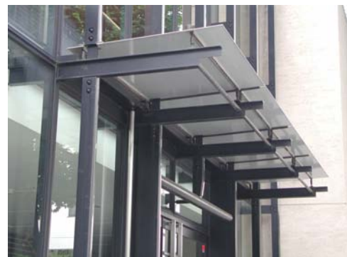
写真-4 C建物 外壁面の状況
