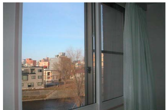
写真-2 採用された二重窓
