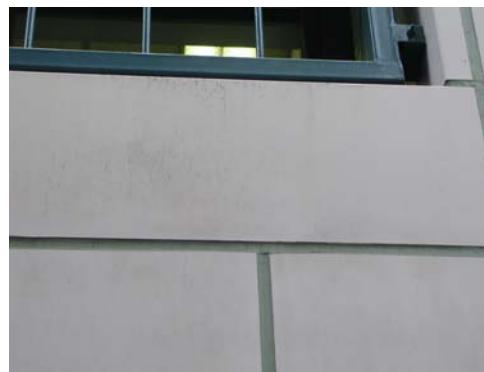
写真-8 F 建物 外壁面の状況
