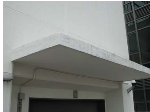
写真-6 E 建物 底鼻先の汚れ状況
