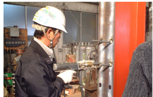
図-5 スタッドの溶接状況
