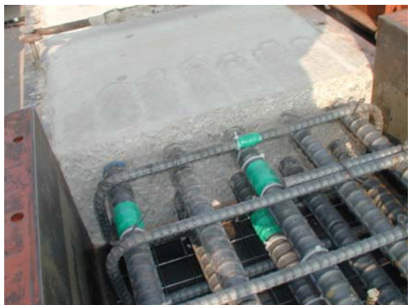
写真-2 打ち継ぎ目処理
