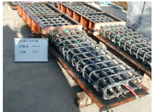
写真-1 配筋状況
