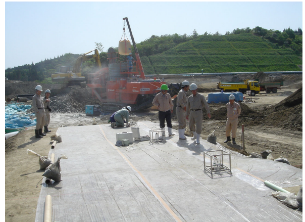
写真-3 現場透水試験状況
