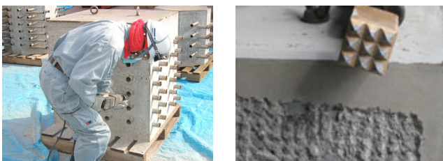
写真-1 目粗し処理（びしゃん仕上げ）
