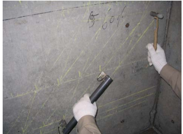
写真-1 測定角度が45度の測定状況
