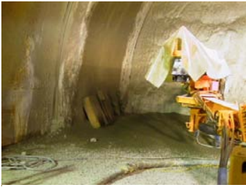
写真-7 付着強度試験供試体採取
