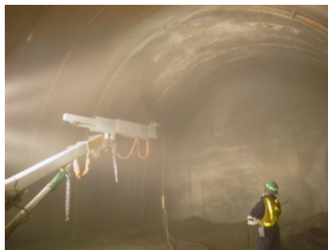
写真-6 エア吹付け方式による粉じん発生状況
