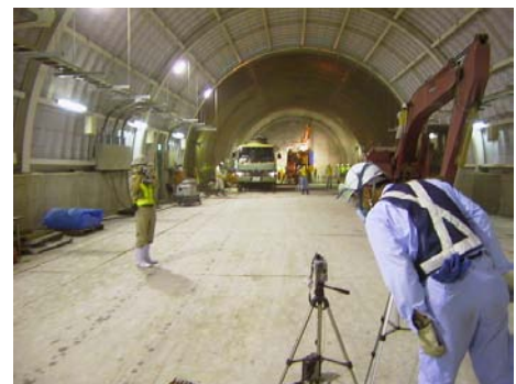
写真-4 粉じん計測状況
