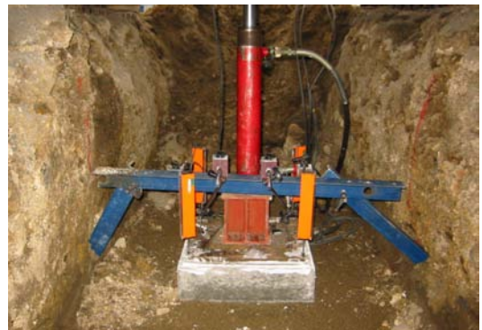
写真-1 載荷試験状況
