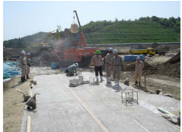
写真-3 現場透水試験状況
