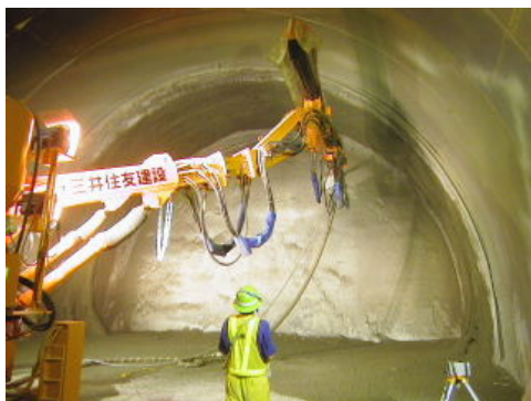
写真-5 遠心力吹付け方式による粉じん発生状況
