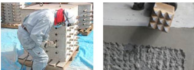
写真-1 目粗し処理 (びしゃん仕上げ)
