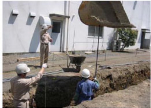
写真-2 杭部材打設状況
