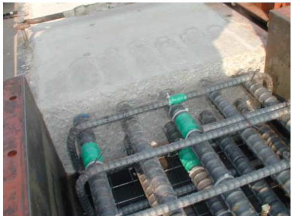
写真-2 打ち継ぎ目処理
