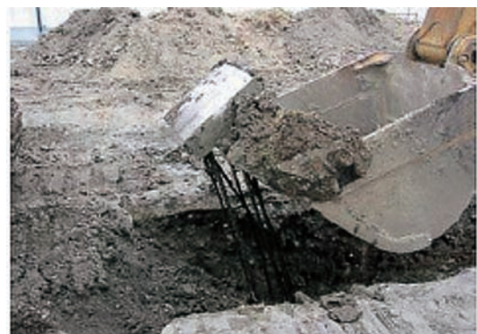
写真-1 基礎撤去状況
