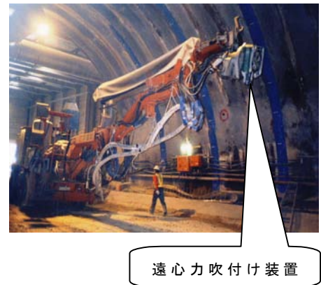
写真-1 遠心力トンネル吹付け機
