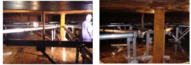
写真-4 フローティングネット組立状況
