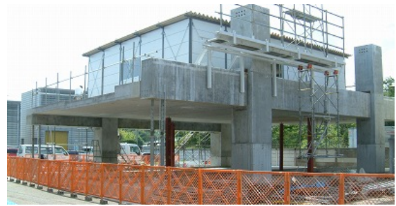
写真-1 実大架構試験体
